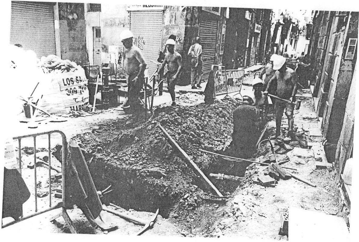
Vista general de les obres de canalització d'aigües.
